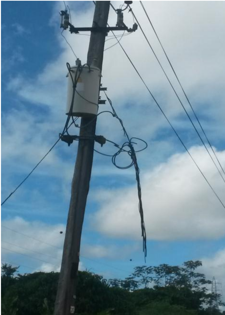
Foto: (EBS Grid) Laagspanningsnet Martin Luther Kingweg onder spanning gesloopt
