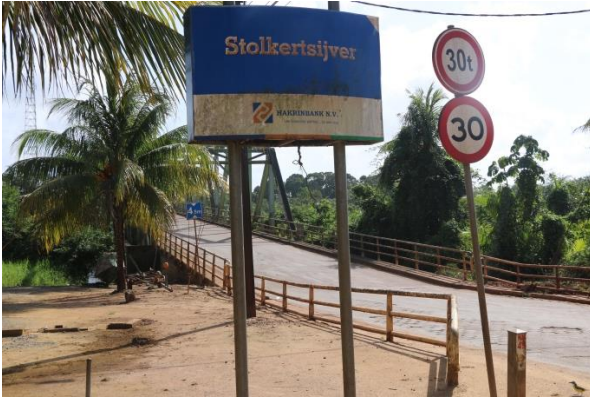
Plate 7: Bridge over Commewijne River- Stolkertsijver
